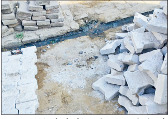
महम। अजायब गांव में कंक्रीट की गली के ऊपर बिना मलबा उठाए बिछाई जा रही इंटरलॉकिंग टाइल्स। फोटो: हरिभूमि
